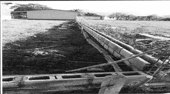
FOTO 2: SE OBSERVA EL LEVANTAMIENTO DE MURO PERIMETRAL
