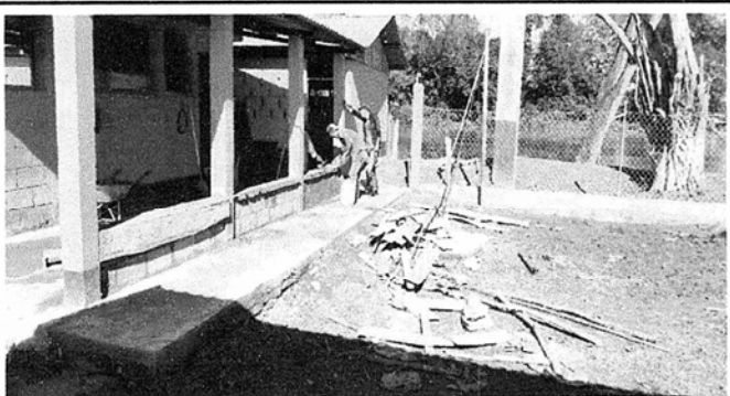
FOTO 9: SE OBSERVA LA INSTALACIÓN DE PORTÓN DE METAL
