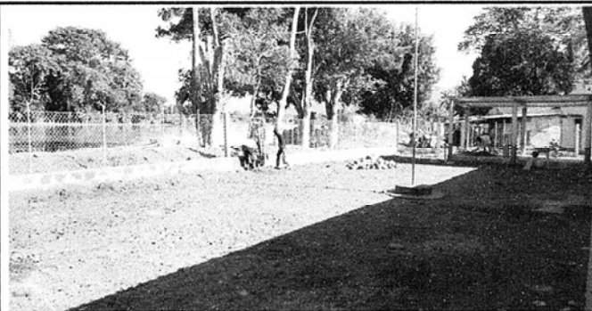
FOTO 6: SE OBSERVA LA COLOCACIÓN DE MALLA GALVANIZADA
