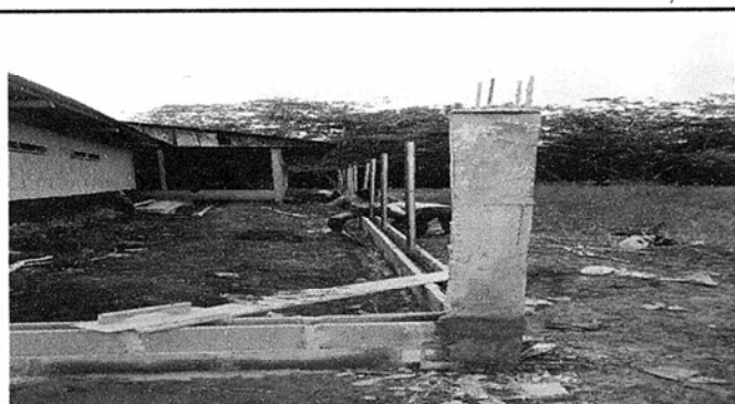
FOTO 3: SE OBSERVA LA INSTALACIÓN DE TUBO HG
