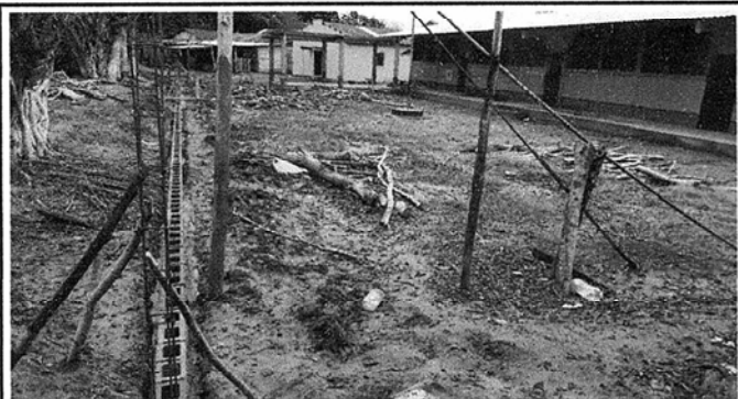
FOTO 1: SE OBSERVA EL LEVANTAMIENTO DE MURO PERIMETRAL
